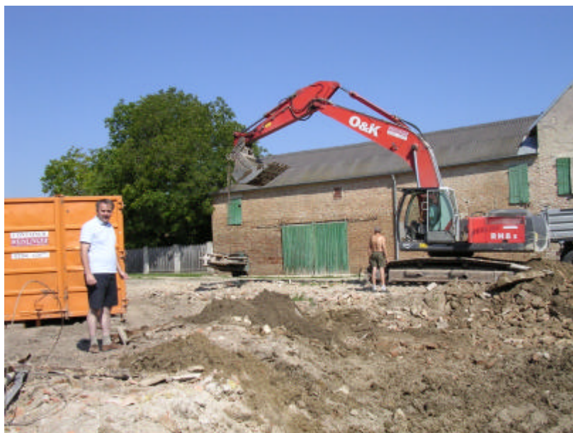
Der Abbruch des ehem. Kaufhauses Holzer wurde bereits abgeschlossen. Mit dem Neubau des Kindergartens soll im September begonnen werden.
